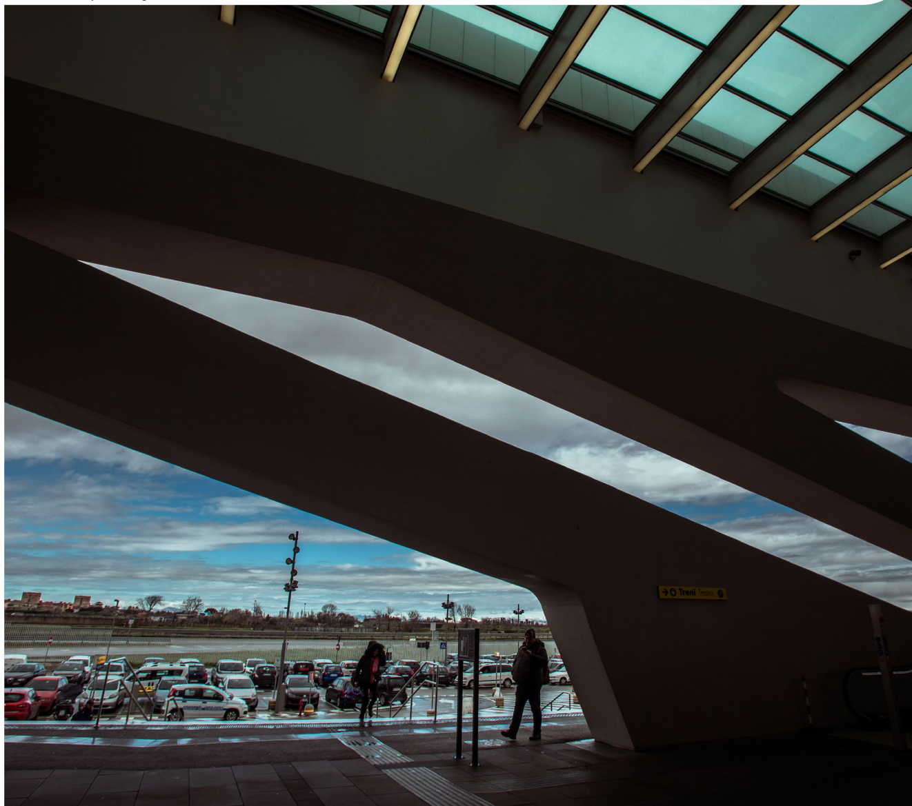
Stazione di Napoli Afragola
