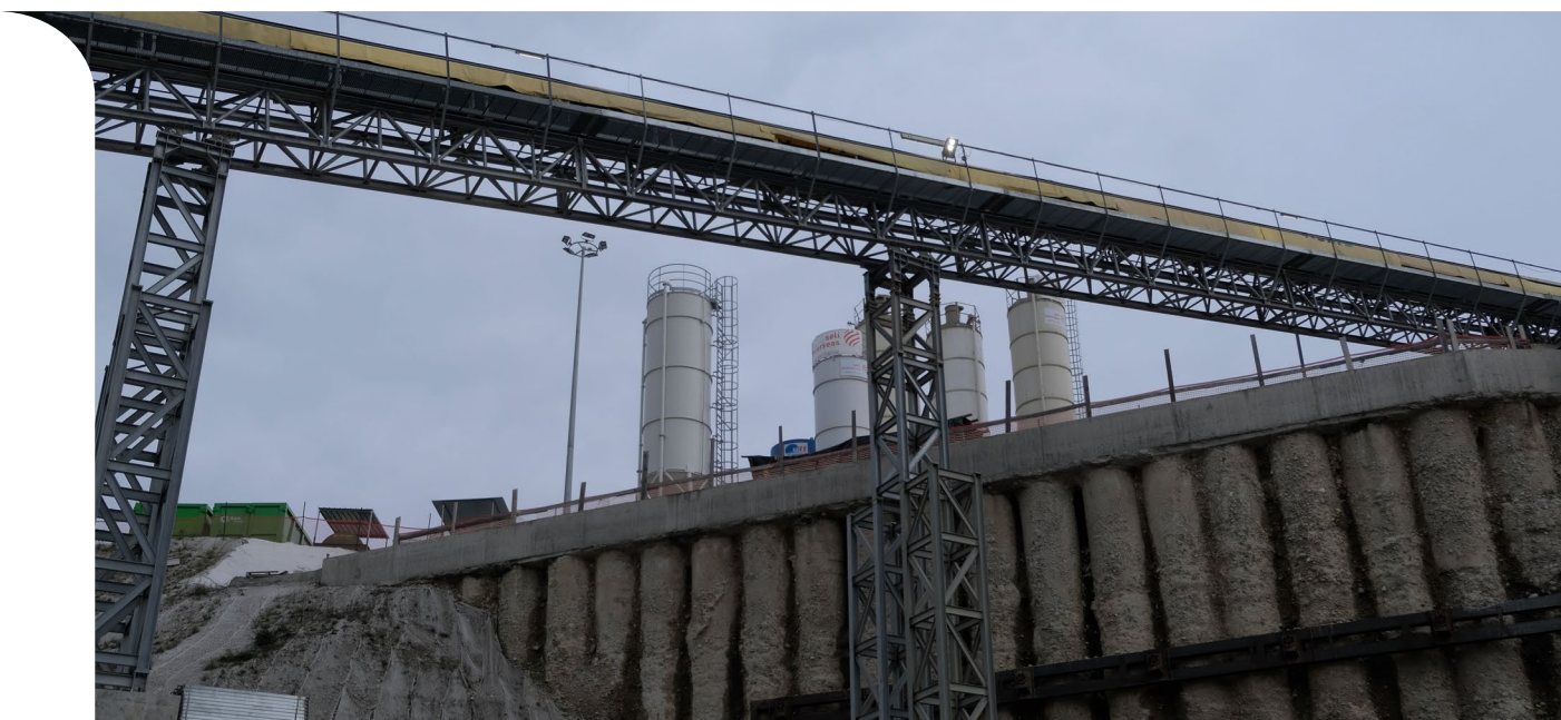
Cantiere per la realizzazione della Galleria Lonato
