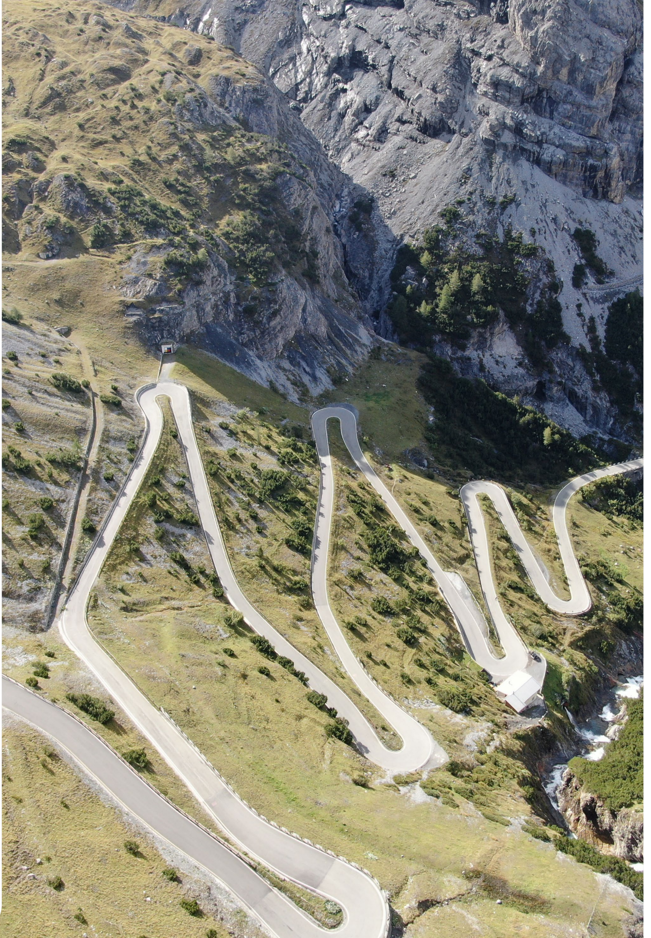
Strada Statale dello Stelvio, Anas
