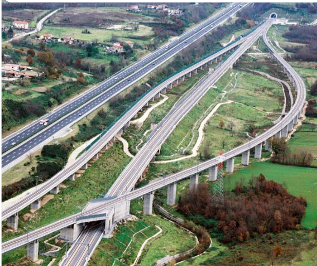
Realizzazione linea AV/AC Napoli-Bari
