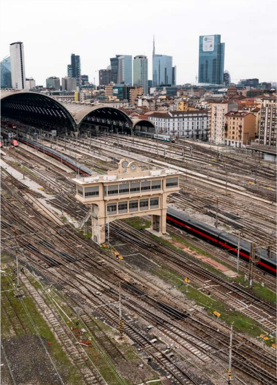
Scalo ferroviario di Milano Centrale
