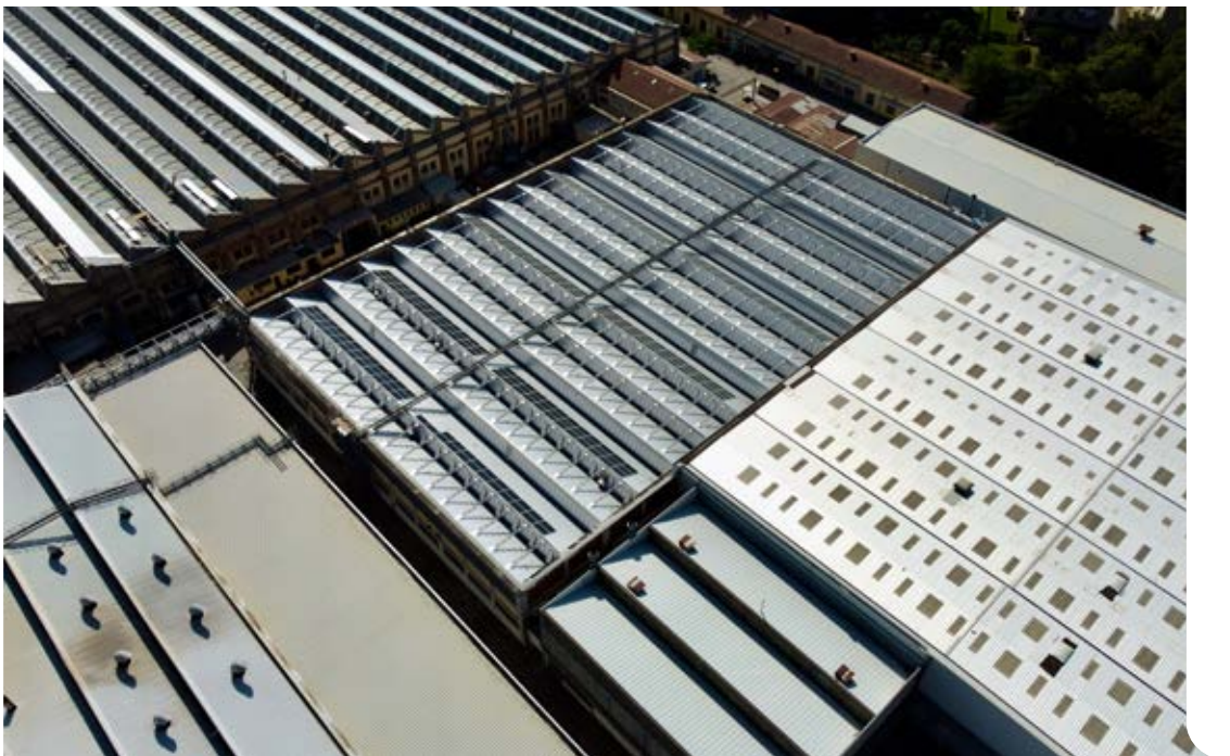
Impianto fotovoltaico OMCL Foligno
