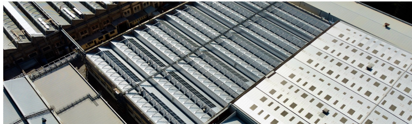
Impianto fotovoltaico OMCL Foligno
