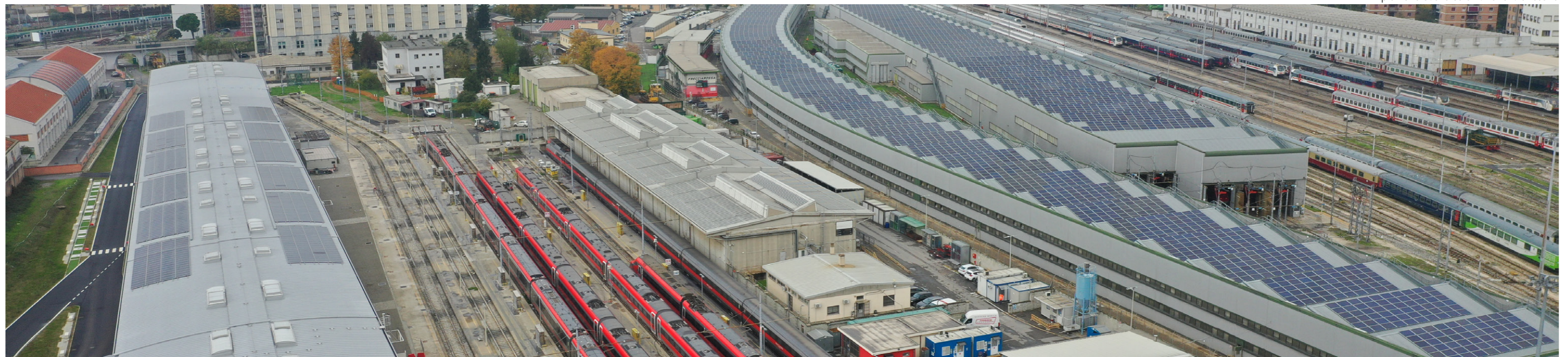
Impianto fotovoltaico di Milano Martesana
