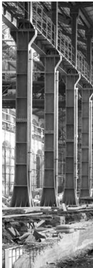
Reparto montaggio. Lavori di restauro per la realizzazione del Museo Nazionale Ferroviario (1980)
