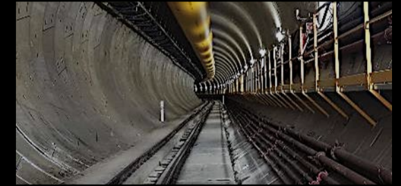
Sottoattraversamento di Firenze
