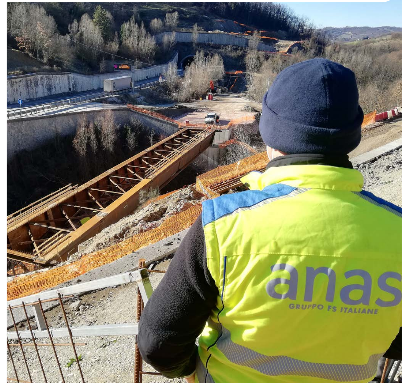
Cantiere stradale Anas
