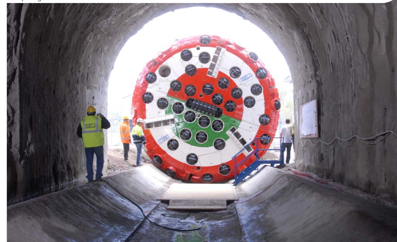
Scavi per la galleria del Brennero
