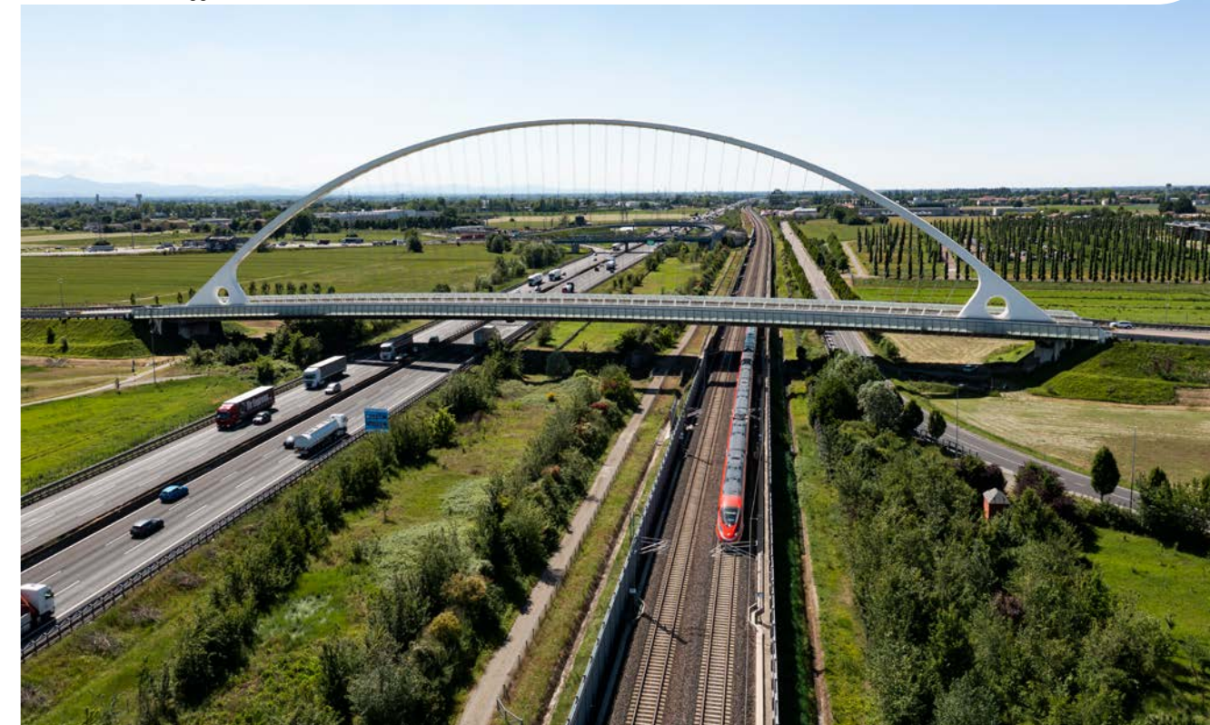
Ponte di Calatrava, Reggio Emilia
