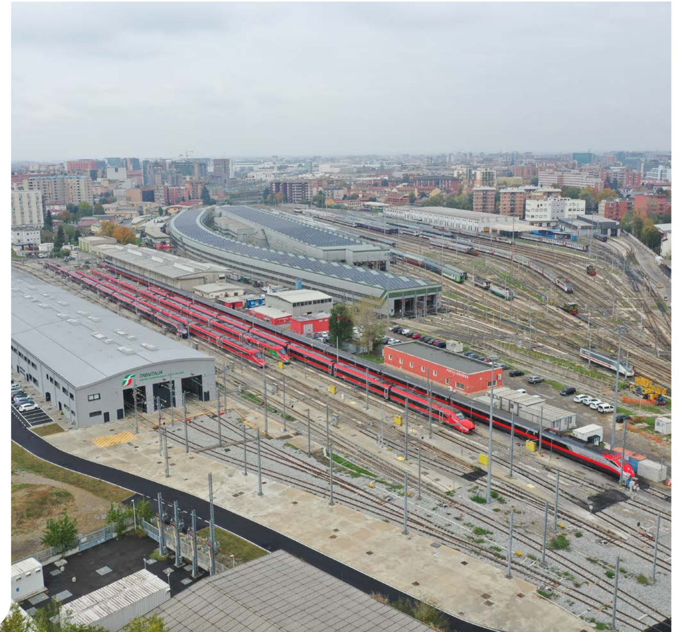
Impianto fotovoltaico di Milano Martesana
